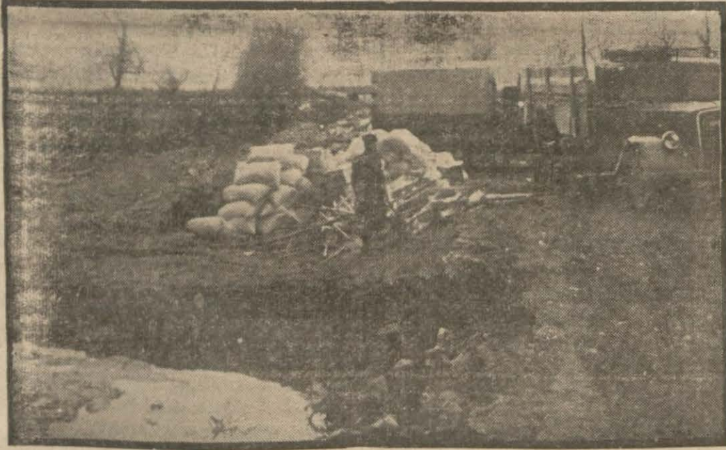
İlk erzak kafelesi Niksarda
